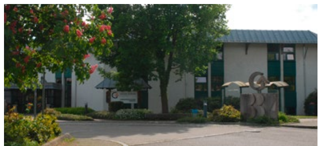
Internat an der Gewerbeakademie Schopfheim
