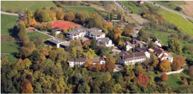
Luftbild der Tüllinger Höhe vor dem Abriss des Altbaus
