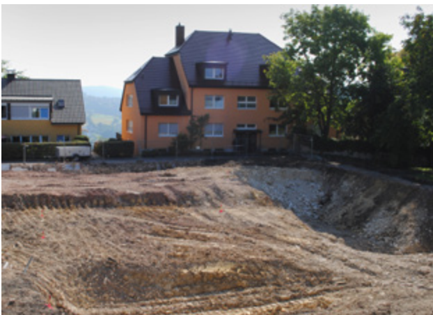
Der abgeräumte Baugrund im September
