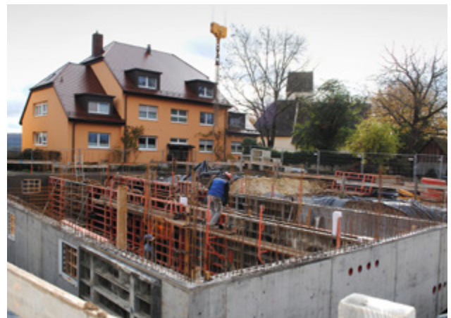
Mitte November stehen bereits die Kellerwände
