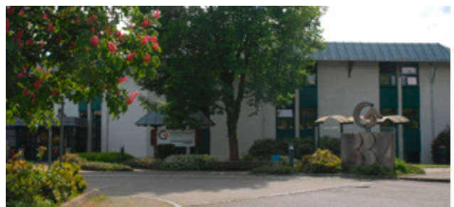
Internat an der Gewerbeakademie Schopfheim
