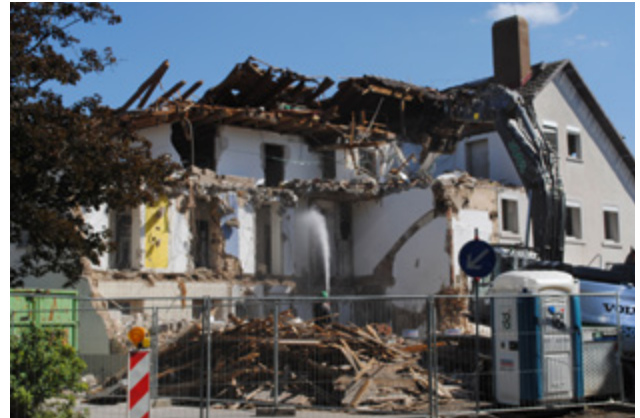
Bald nach dem Abschiedsfest rückten die Bagger an und vier Wochen später war das große Gebäude fein sortiert in seine Einzelteile zerlegt.
