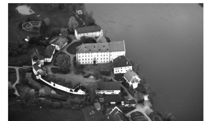
Das Schlossareal von Beuggen – rechts am Rhein liegt die Mühle; das Torhaus liegt links neben dem oberen Tor. Unten in der Mitte steht unser Schulhaus
