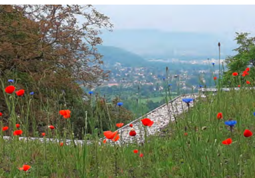
Dachbegrünung des Neubaus
