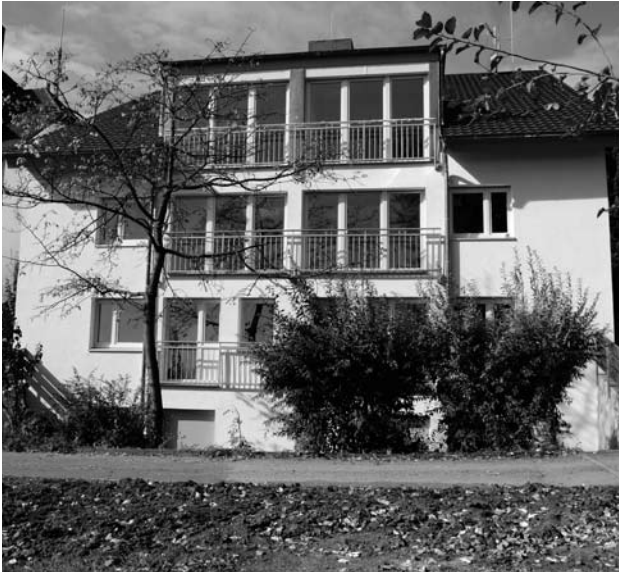
... und nach der Renovierung
