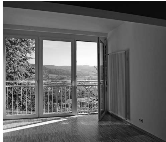
Durch die Umwandlung der Dachbalkone in Gauben wurden die Wohnzimmer größer und heller
