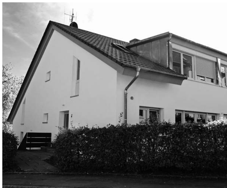
Haus 106 von Nord-Osten
